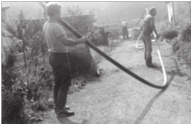
Bau einer Wasserleitung in der Sparte „Grüne Aue“ des Kreisverbandes Aue
